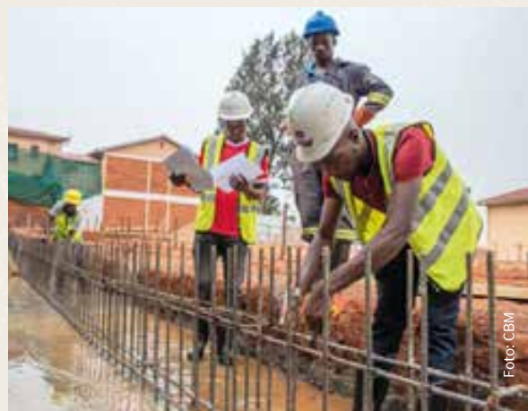
↑ Die Arbeiten an der neuen Klinik laufen auf Hochtouren.
